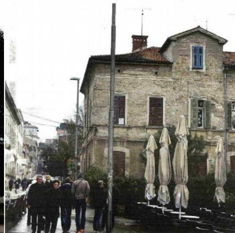
Obnovit će se i zgrada u Planatićkoj 12
